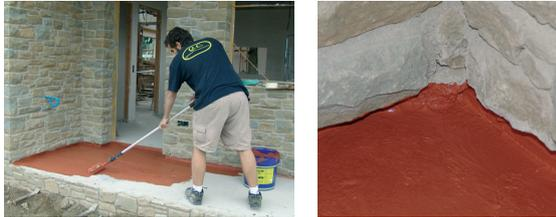
**ELASTEL-2**, es un compuesto a base de copolímeros acrílicos, absolutamente impermeable al agua y de gran elasticidad, los dos parámetros imprescindibles para dar solución a todos los problemas de impermeabilización de aguas en cubiertas y terrazas en el mundo de la construcción. Su especial composición le permite solar directamente encima.
